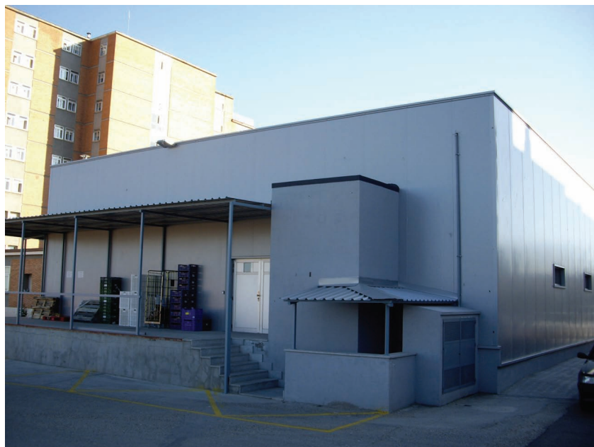
Vista del edificio de cocina
